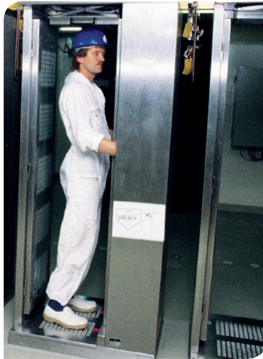
Abb. 12.03 Prüfung auf radioaktive Kontamination am Ganzkörpermonitor
